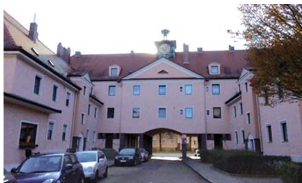
Abb. 1: Südsicht der Margaretenau 36 mit historischem Glockenturm, Quartier Margaretenau
