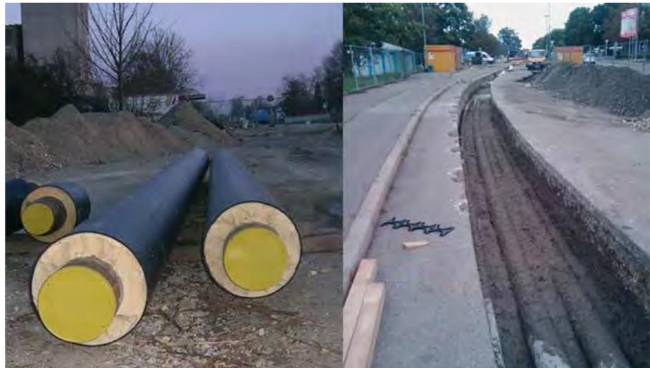
Abb. 1: Im Fernwärmeleitungsbau eingesetztes Kunststoffmantelrohr (KMR) mit Stahlinnenrohr, PUR-Schaumdämmung und PEHD-Mantel, rechts: mit ZFSV teilverfüllte KMR
