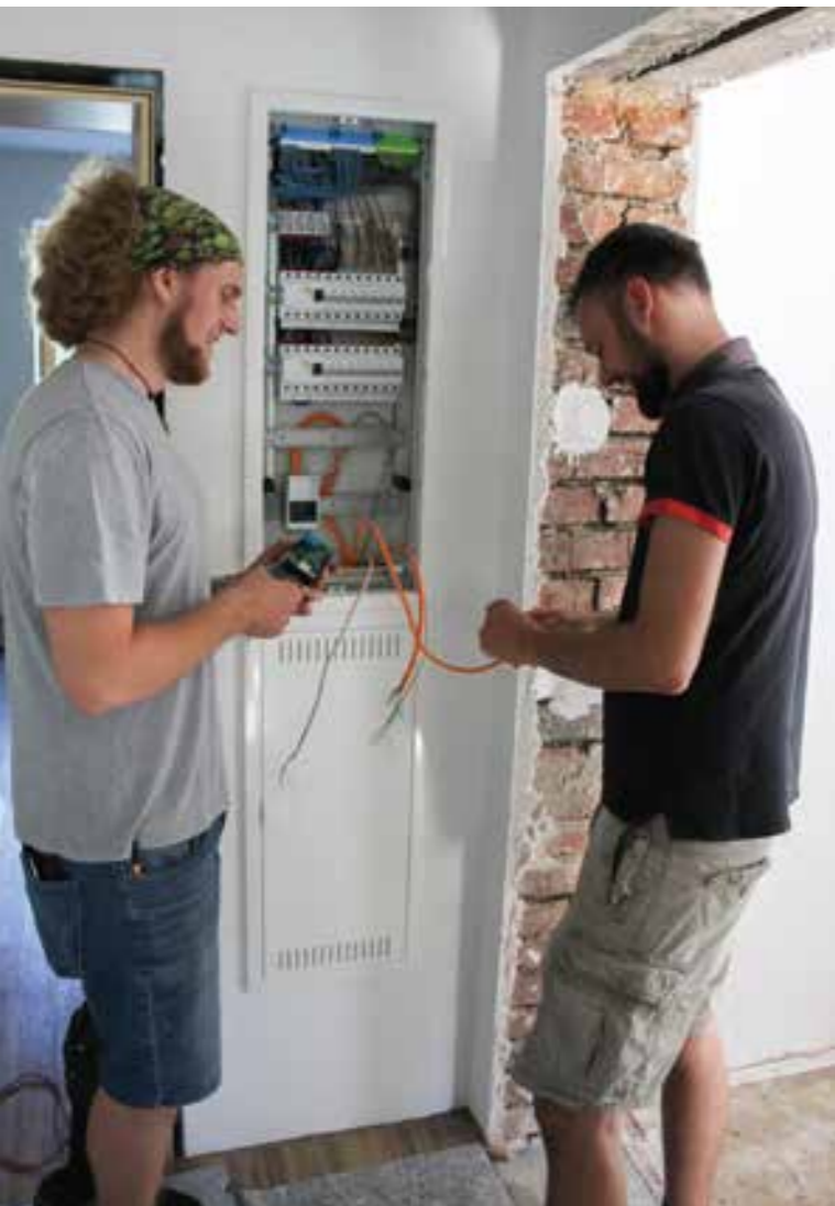
oben: Projektkoordinator Michael Riederer (rechts) und Projektmitarbeiter David Michlbauer vor dem Schaltkasten einer Wohnung: Die orangefarbenen Kabel verbinden das BUS-System mit der KI-gestützten Planungs- und Steuerungssoftware im Keller.
