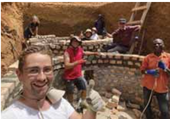
Gut gelaunt bei der Arbeit: Die Studierenden der OTH Regensburg bauen die Mauern für die Zisternen an der IMLS in Masaka. Die Wassertanks, die dort Platz finden, fassen 10.000 Liter Regenwasser. Foto: Privat/Andreas Dirscherl
